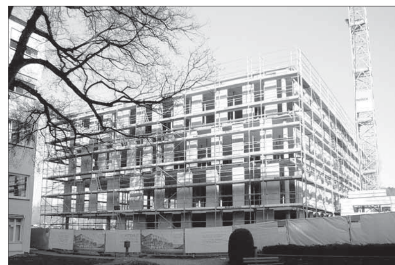
Die Baumaßnahmen des Ärztelhauses am Krankenhaus St. Elisabeth in Ravensburg gehen in die letzte Phase. Die Eröffnung soll Anfang kommenden Jahres sein. Foto: Krankenhaus St. Elisabeth
